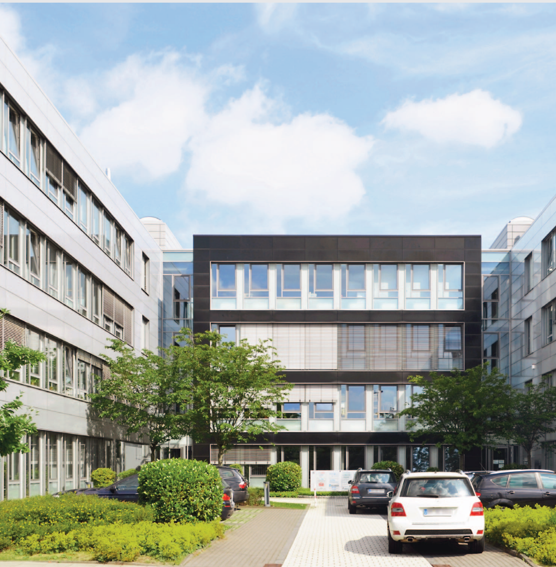
Verwaltungsgebäude in Frechen bei Köln, Europaallee
