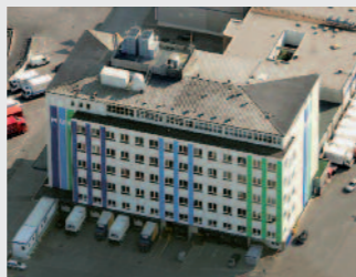
Hamburg Logistikzentrum Hamburg Lagerstraße
