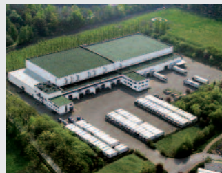
Hannover Logistikzentrum Garbsen
