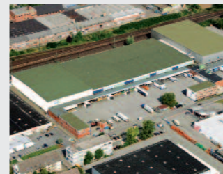
Mannheim Logistikzentrum Mannheim-Neckarhausen
