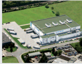
Flörsheim Logistikzentrum Flörsheim
