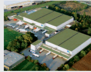
Heppenheim Logistikzentrum Heppenheim I
